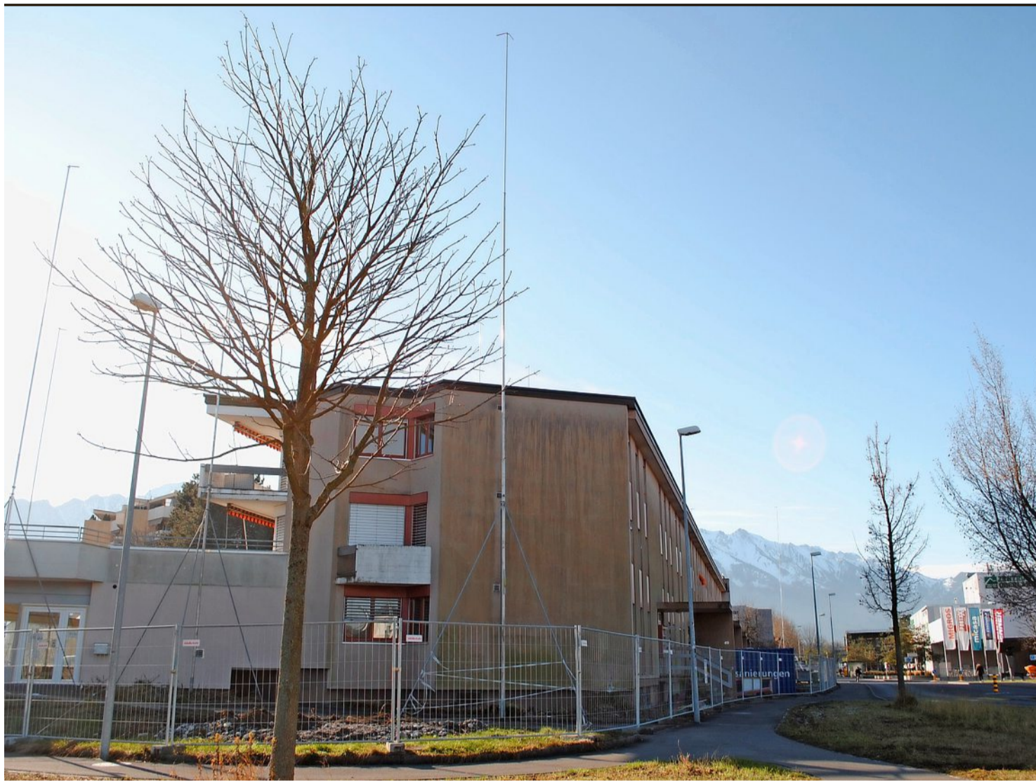
Das Bild zeigt die alte Überbauung und die Profile für die neue. Rechts im Hintergrund das Migros-Zentrum Oberland. Foto: Michael Gurtner
